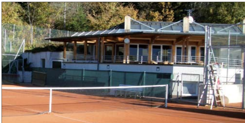
Das neue Clubgebäude des TCA-Tennisclub Absam nach der Fertigstellung.
